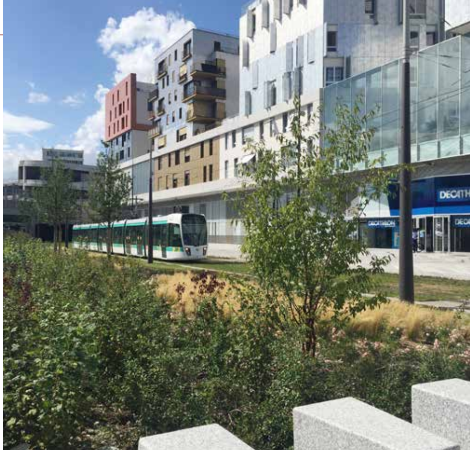
Le nouveau quartier Rosa Parks Macdonald dans le XIX e arrondissement de Paris.
